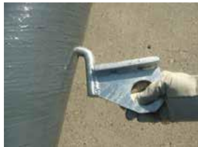
شکل (۱۰) - قلاب‌های مهار در سوراخ‌های روی پایه قرار می‌گیرد
