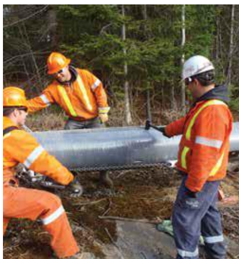
ج) ضربه زدن با چکش لاستیکی بر روی قطعه کوچکتر (بالایی) جهت اتصال بهتر دو قطعه
