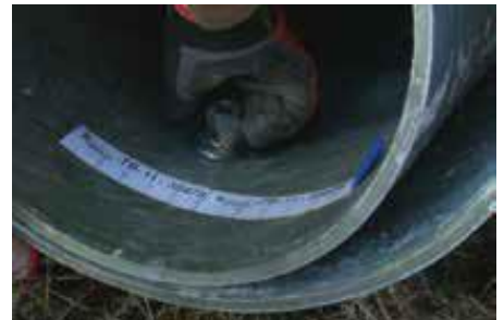
الف) باز کردن پیچ و مهره نگهدارنده قطعات
