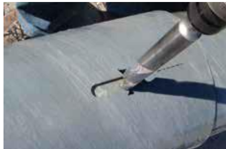
ب) دریل با استفاده از مته الماس
