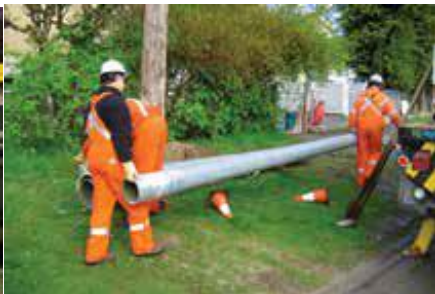
ب) چیدن قطعات در یک راستا بر روی زمین جهت مونتاژ
