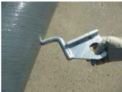
شکل (۱۰) - قلاب‌های مهار در سوراخ‌های روی پایه قرار می‌گیرد
