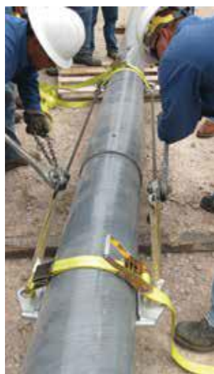
ب) کشیدن دو قطعه به داخل یکدیگر با استفاده از تیرفور
